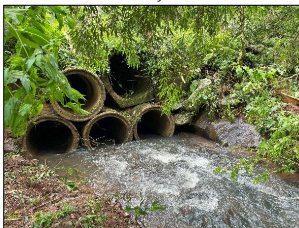
Figura 181. Arroio a jusante do ponto de medição.
