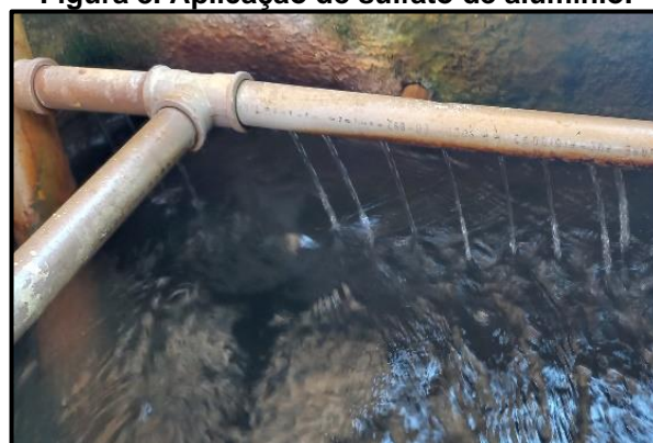
Figura 8. Aplicação de sulfato de alumínio.
