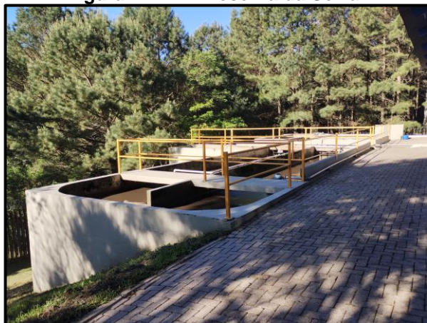
Figura 77. ETE Reserva da Serra.
