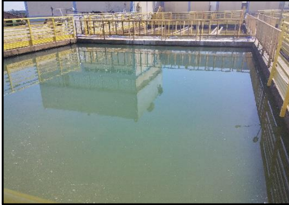
Figura 25. Decantador primário.
