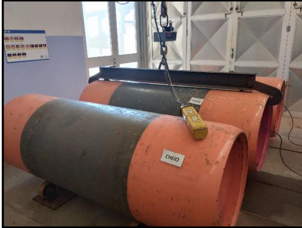
Figura 29. Cilindros de cloro gás.
