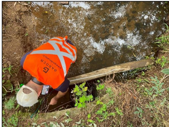
Figura 189. Execução da medição.
