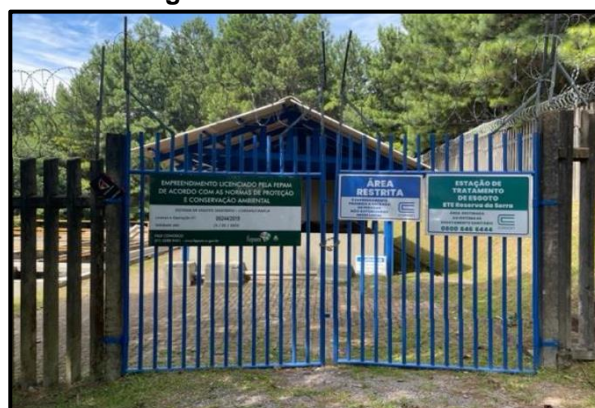
Figura 76. Entrada da ETE
