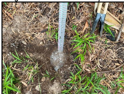
Figura 121. Ensaio de infiltração 02.
