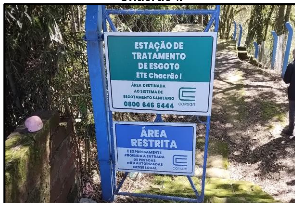
Figura 61. Estação de Tratamento de Esgoto Chacrão I.
