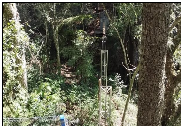
Figura 63. Estrutura que iria se integrar a ETE Renascer.
