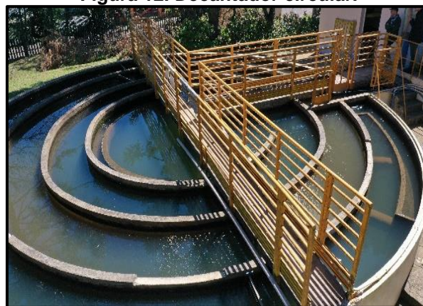
Figura 12. Decantador circular.
