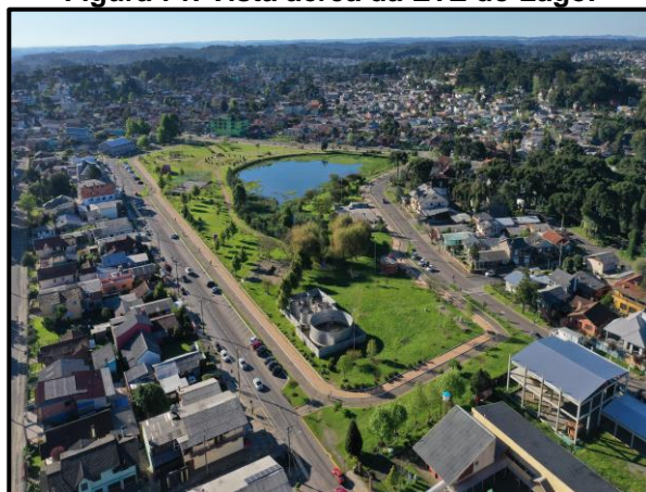
Figura 71. Vista aérea da ETE do Lago.
