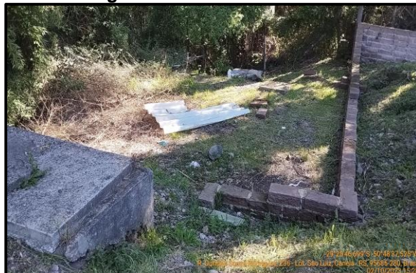
Figura 67. ETE Fossa Filtro.
