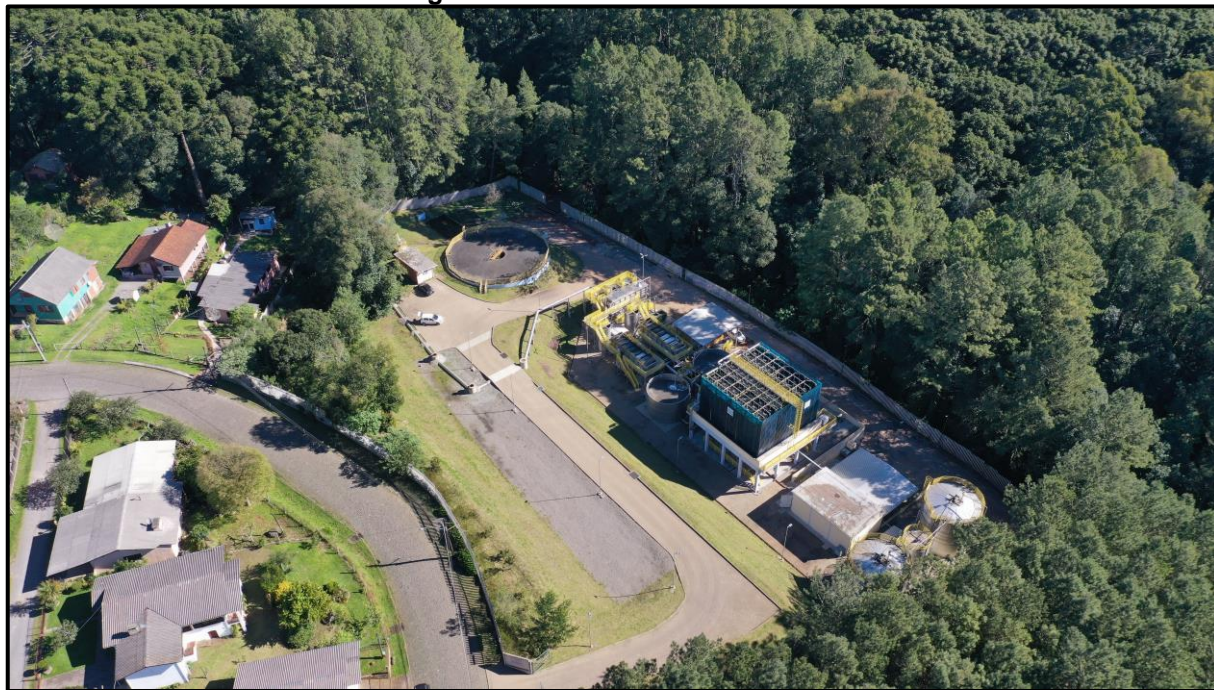
Figura 80. ETE - Santa Terezinha.
