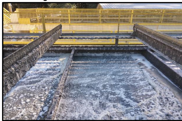
Figura 89. Flotador Mecânico.
