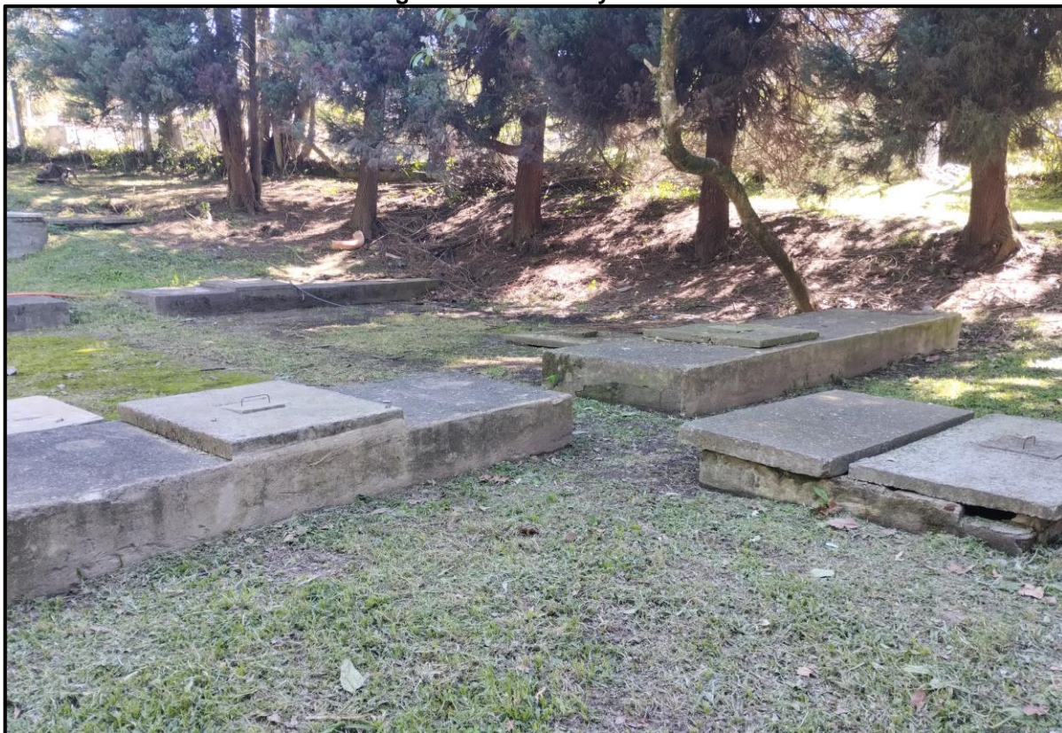
Figura 54. ETE Aracy Corrêa.
