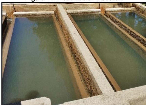
Figura 11. Decantador modular.
