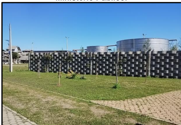
Figura 52. ETA na Vila Miná - Desativada pelo Ministério Público.
