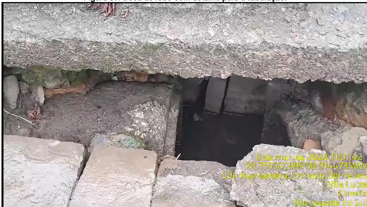
Figura 37. Boca de lobo com detalhe para a tubulação.
