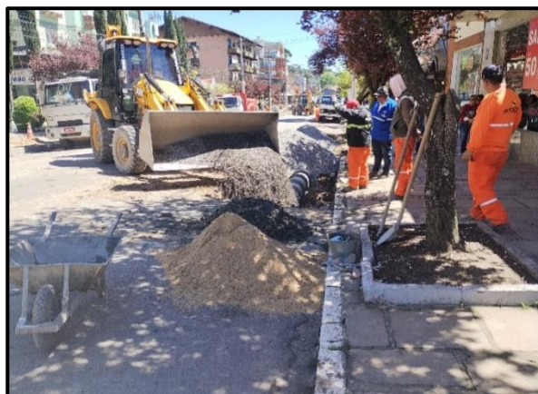
Figura 4. Obras de drenagem em Canela em outubro de 2023.
