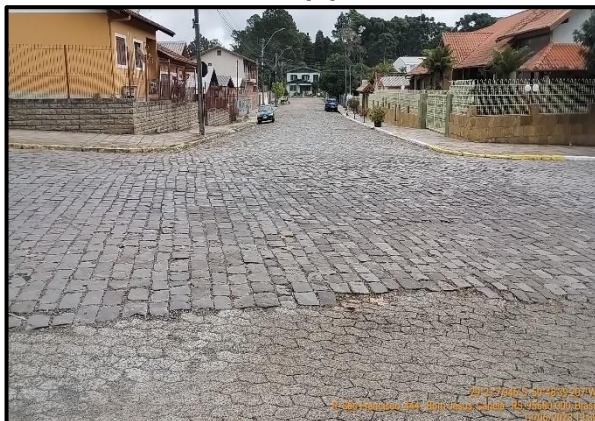
Figura 7. Rua com Pavimentação de Paralelepípedo.
