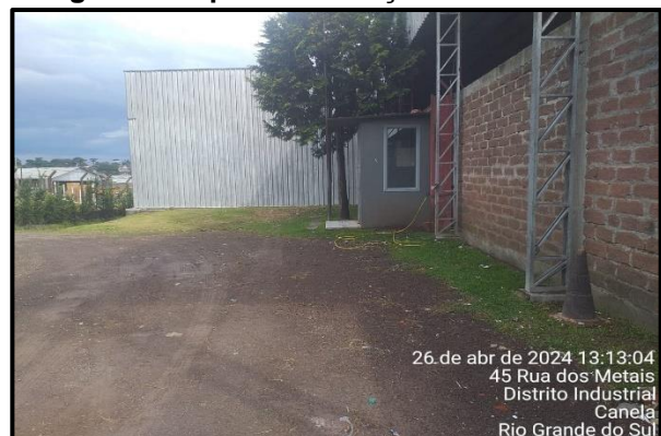
Figura 81. Após intervenção da Prefeitura.
