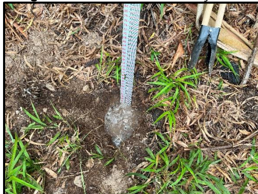
Figura 121. Ensaio de infiltração 02.
