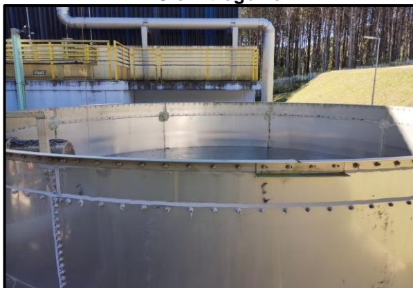
Figura 92. Tanque anóxico - Removedor de DBO e Nitrogênio.
