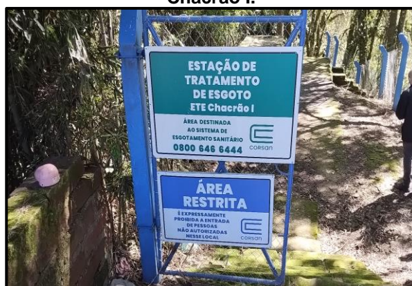
Figura 61. Estação de Tratamento de Esgoto Chacrão I.
