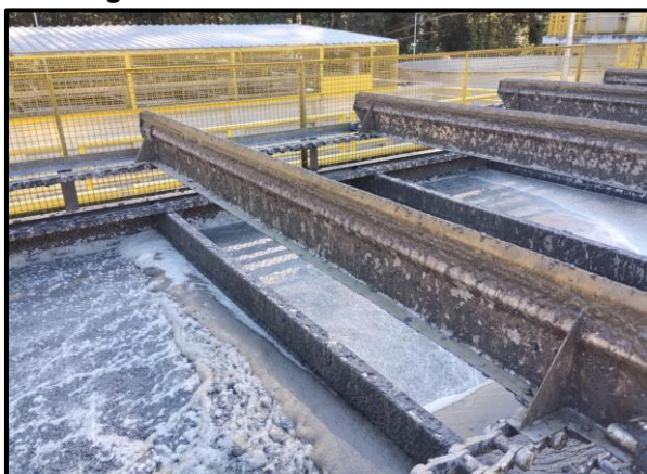
Figura 90. Flotador de ar dissolvido.
