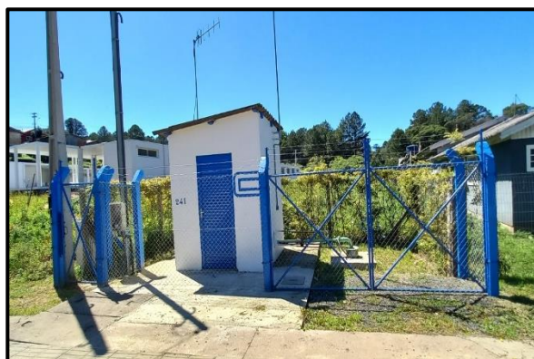
Figura 34. Estrutura do poço Jardim das Fontes.
