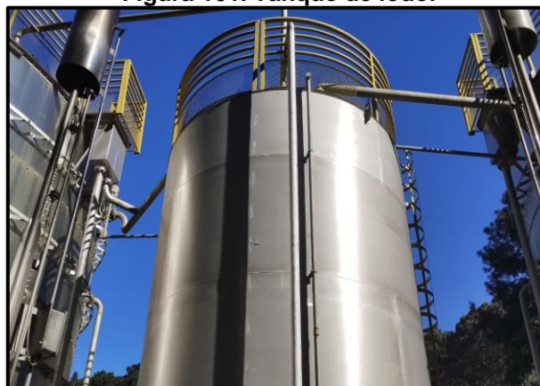
Figura 101. Tanque de lodo.
