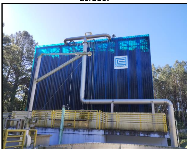
Figura 94. Filtro Biológico – Percolador aerado.
