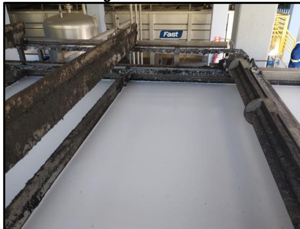
Figura 97. Flotador.
