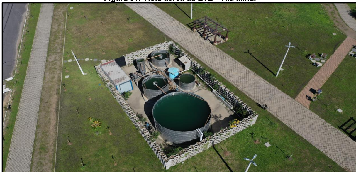
Figura 51. Vista aérea da ETE - Vila Miná.
