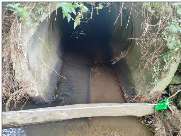
Figura 188. Seção instalada para medição de vazão.
