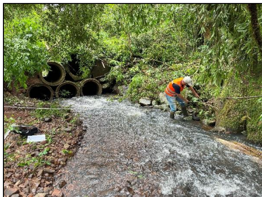
Figura 182. Seção instalada para medição de vazão.
