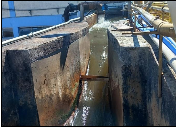
Figura 21. Calha Parshall.
