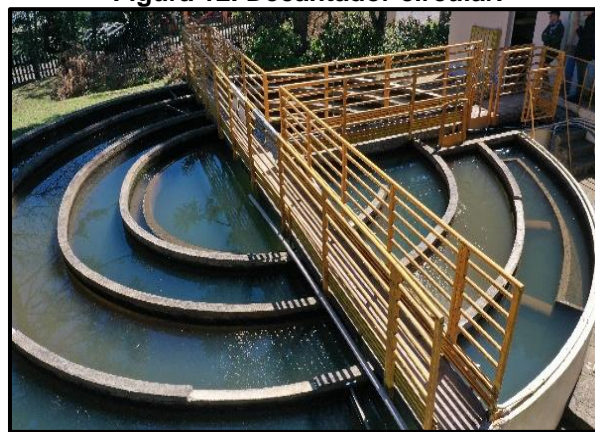
Figura 12. Decantador circular.
