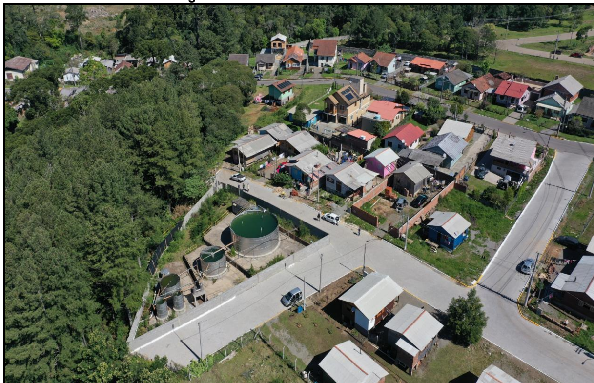
Figura 59. Vista aérea da ETE Renascer.
