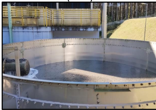
Figura 93. Reator biológico de leito móvel (MBBR)
