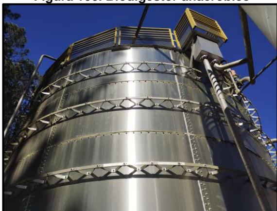
Figura 100. Biodigestor anaeróbico
