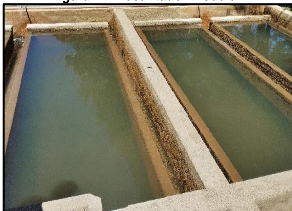
Figura 11. Decantador modular.
