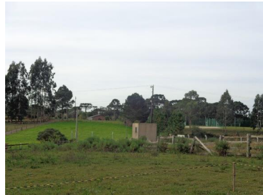
VISTA FRONTAL DO LOCAL DE INSTALAÇÃO
